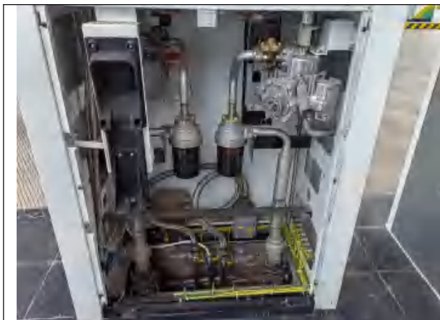
图 7 加油机内部剪切阀
