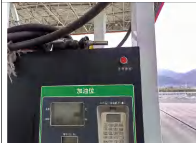
图 9 加油机急停按钮
