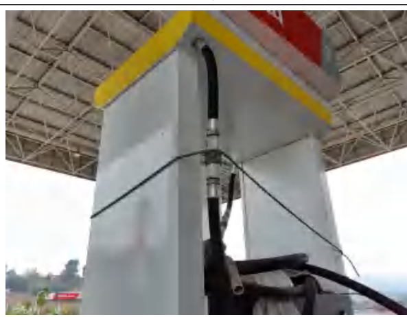
图 10 加油机加油软管拉断阀
