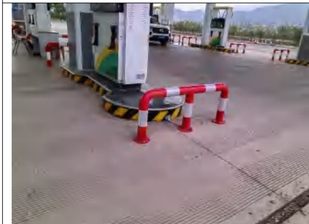
图 11 加油岛端部防撞杆
