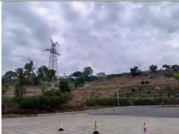
图 27 加油站东北面山地及电力塔
