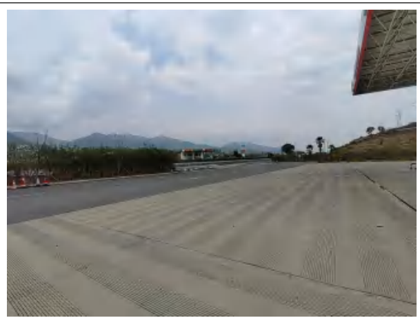
图 30 加油站西面沪宁高速公路
